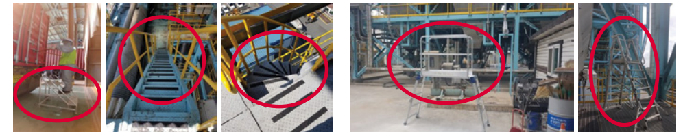
▲ 근로자 전도 방지를 위한 작업대, 미끄럼 방지테이프 설치
