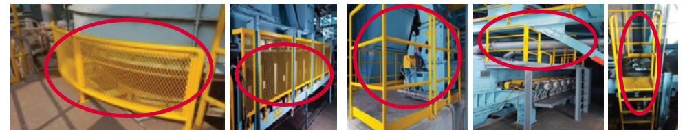
▲ 위험시설(사일로, 컨베이어) 인근 컨테이너 방호울 설치
