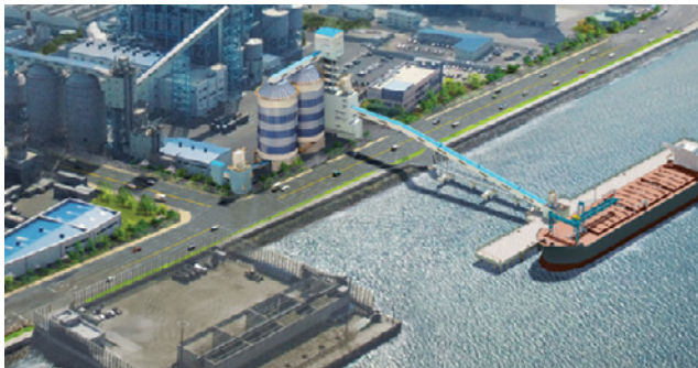
▲ 유연탄 이송 부두 시설 전경
